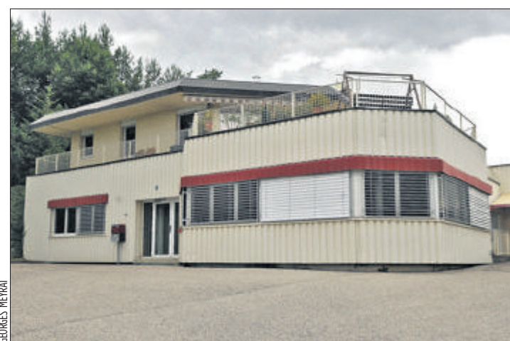
L'Eglise évangélique Chrischona de Lausanne veut transférer ses activités dans ce bâtiment de la zone artisanale d'Echandens.
